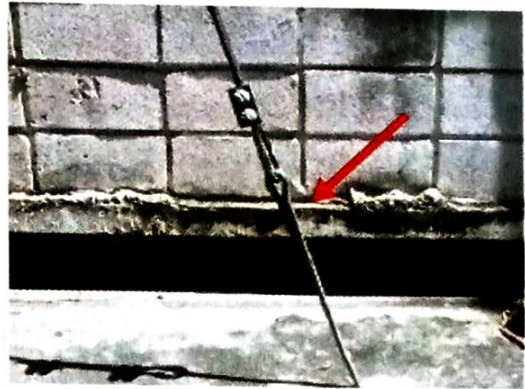
รูปที่ 2.34 ก้านสมอบกและการใช้งาน
