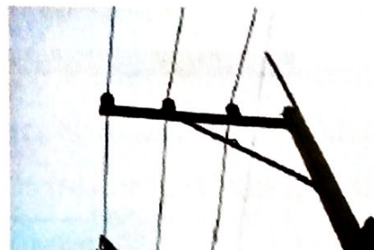
รูปที่ 2.31 เหล็กประกบคอนแบบเท้าแขนและการใช้งาน
