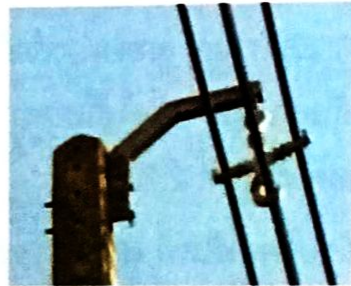
รูปที่ 2.24 เหล็กคอนเคเบิลอากาศทางตรงและการทำงาน
