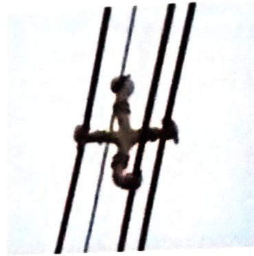
รูปที่ 2.23 เคเบิลสเปเซอร์และการทำงาน
