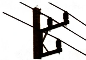
รูปที่ 2.25 เหล็กคอนเคเบิลอากาศทางตรงและการทำงาน
