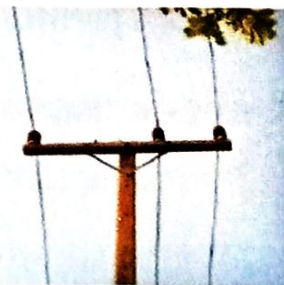
รูปที่ 2.30 เหล็กประกบคอนสายและการใช้งาน
